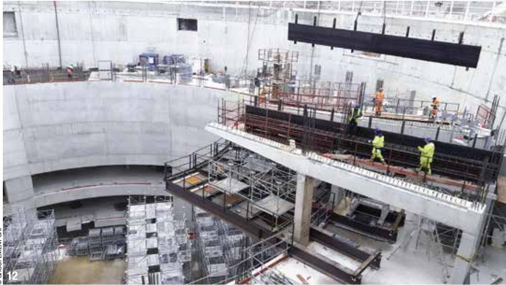
Les trois derniers niveaux de dalle incluent 36 poutres radiales avec 6 m de porte-à-faux vers l'intérieur du puits, non répétitives, d'inertie variable et des planchers d'épaisseur variant de 50 cm à 1,20 m. Des châssis métalliques H600 en porte-à-faux brêlés sur le plancher inférieur (figure 12) sont
