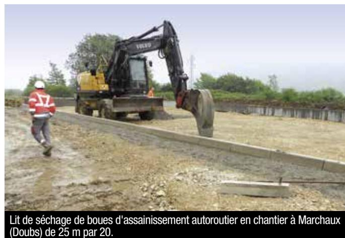
**Lit de séchage de boues d'assainissement autoroutier en chantier à Marchaux (Doubs) de 25 m par 20.**
