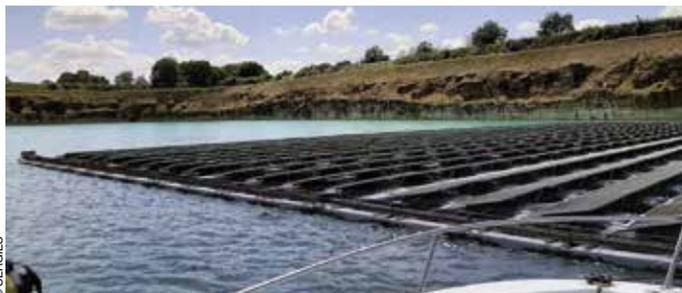
À Saint-Maurice-la-Clouère (Vienne), une ancienne fosse d'extraction de calcaire, remise en eau, reçoit une centrale photovoltaïque de 3 MW.
