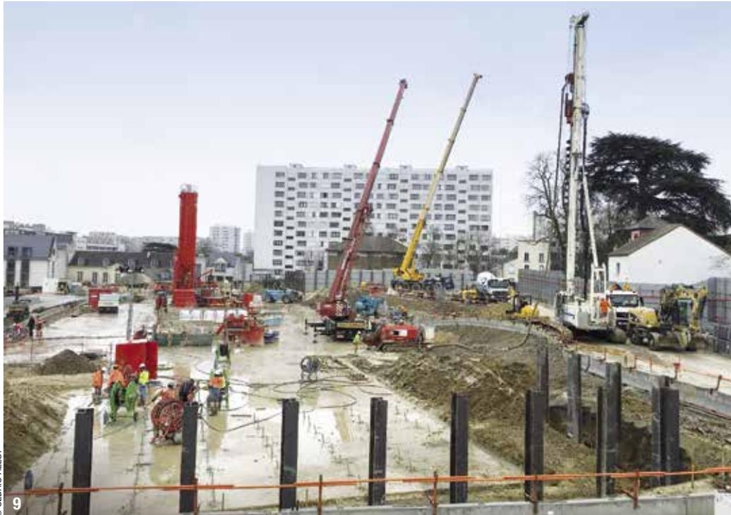
**9- Travaux de pieux berlinois et injection du bouchon d'entrée en terre du tunnelier.**
