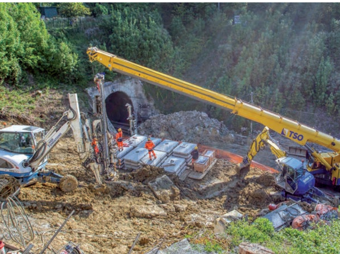
Renforcement urgent de talus ferroviaire, chantier test pour de nouvelles méthodes de travail.
