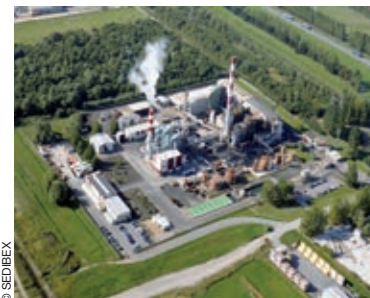
La vapeur provient de l'usine de traitement de déchets de Sandouville.
