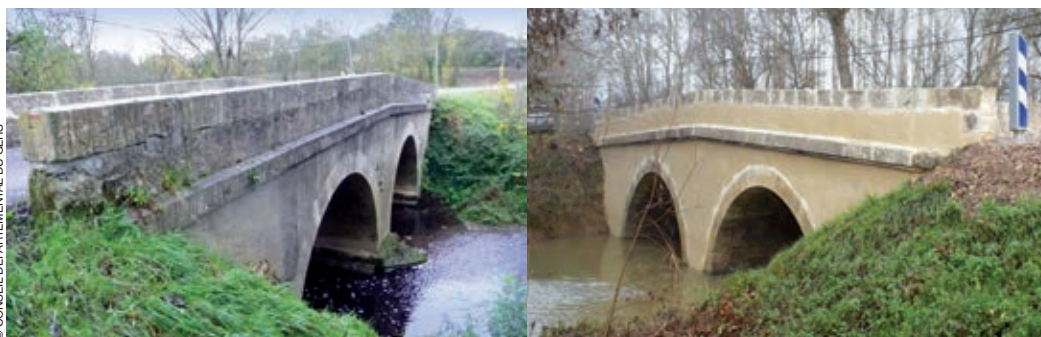
Pont sur la RD 168 dans le Gers, avant et après reconstruction des parapets maçonnés, rejointement des pierres de voûtes, piquage de l'enduit au ciment et réalisation d'un enduit à la chaux, et étanchéité supérieure.
