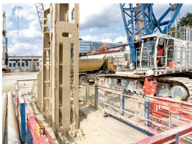
Le forage des parois moulées est une tâche éprouvante pour les personnels, en particulier l'aide foreur chargé de la pose des garde-corps avant intervention, de l'aide au positionnement de l'outil, de la réalisation des mesures sur les parois (verticalité, niveau de boue, etc.), du retrait des garde-corps et de la pose des
