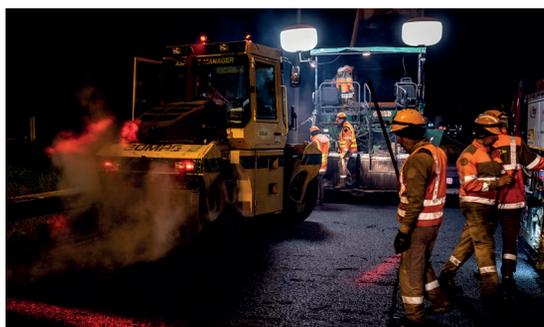
Pour autant, le travail de nuit est une obligation pour limiter les problèmes de circulation et d'embouteillage. C'était le cas sur un chantier aux abords de la Métropole de Lyon où rabotage, balayage du support, mise en œuvre et compactage des enrobés, contrôles laboratoire intérieur et extérieur et mise en œuvre de la signalisation horizontale étaient réalisés entre 21h30 et 5h du matin.
