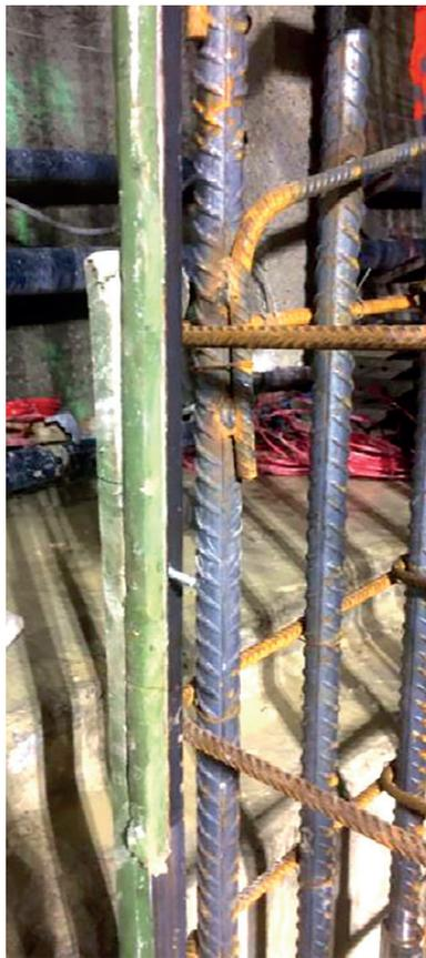
le système permettant son installation dans les parois moulées en utilisant les armatures, sans avoir recours à un système de coffrage additionnel.
