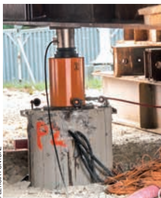
Chaque amas de poutres repose sur un pieu de 50 cm de diamètre descendant à 15-21 m de profondeur, au-dessus ou en bordure du tunnel, et instrumenté afin de relever son comportement.
