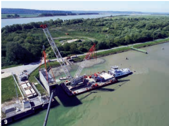
9- Dépose de la porte aval de la nouvelle écluse de Tancarville.
