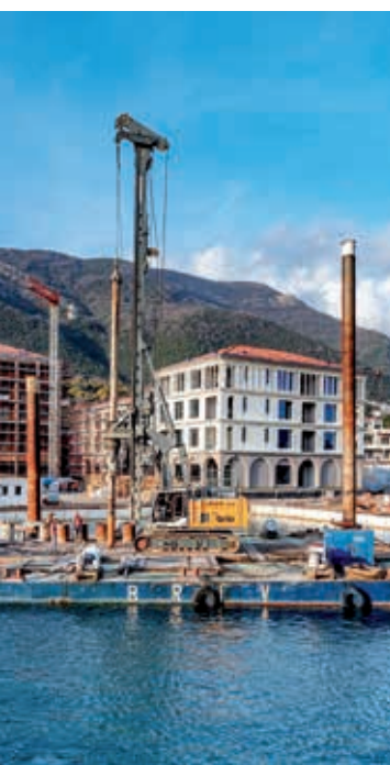
L'entreprise de fondations profondes œuvre à partir d'une barge à Kumbor (Monténégro).
