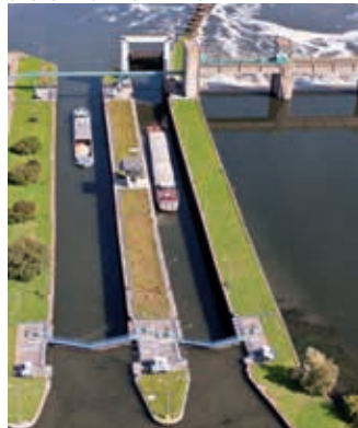
Les deux écluses vont être mises à la même longueur, 180 m.
