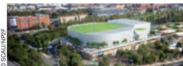
Deux ans de chantier.
