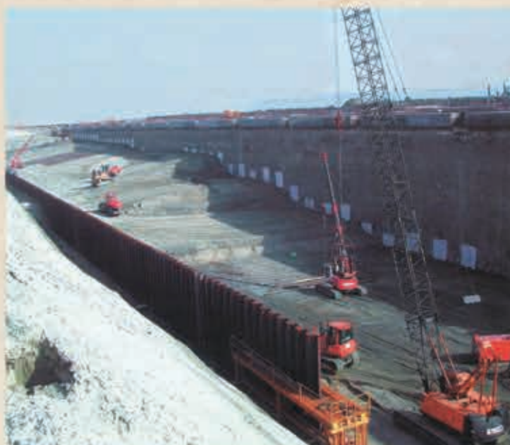
Photo 3 Palplanches, tirants et remblais en arrière du quai
