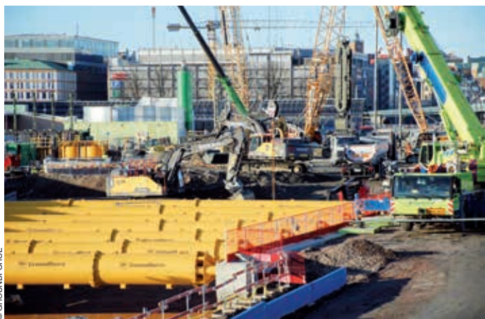
Le centre de Göteborg (Suède) pourra être traversé en transport en commun et en souterrain. 30 butons soutiennent les parois de tranchées couvertes et celles de la nouvelle gare à 10 m de profondeur.
