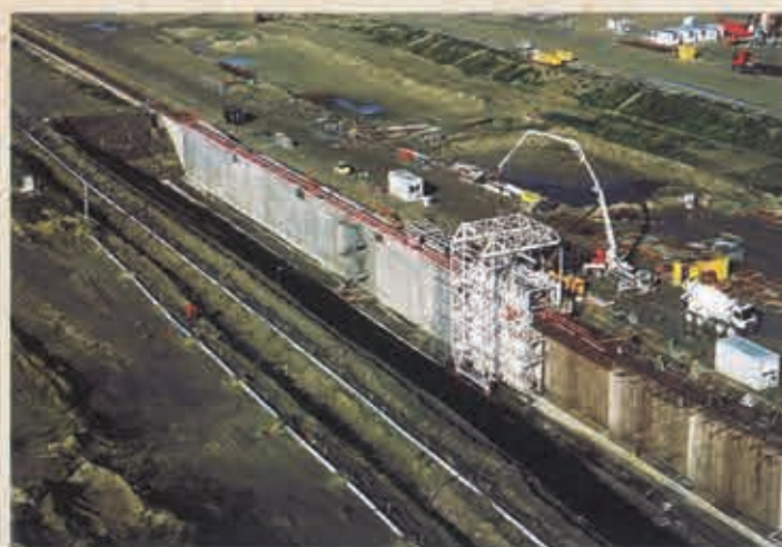
Photo 2 Réalisation du génie civil de la poutre de couronnement Performance of civil engineering for the coping girder
