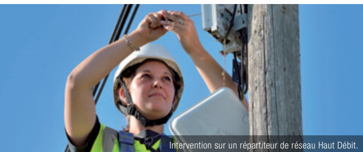
Intervention sur un répartiteur de réseau Haut Débit.
