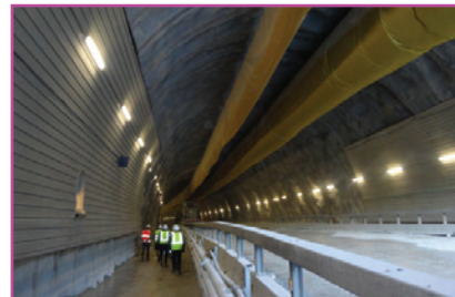
Tunnel de la Borne Roamine : visite du chantier.
