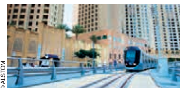
Tramway alimenté par le sol, développé par Alstom.
