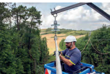
Réparation d'une ligne électrique Enedis.
