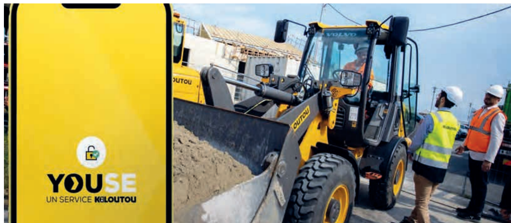
L'application Youse permet de rationaliser les engins de la marque, présents sur un chantier.
