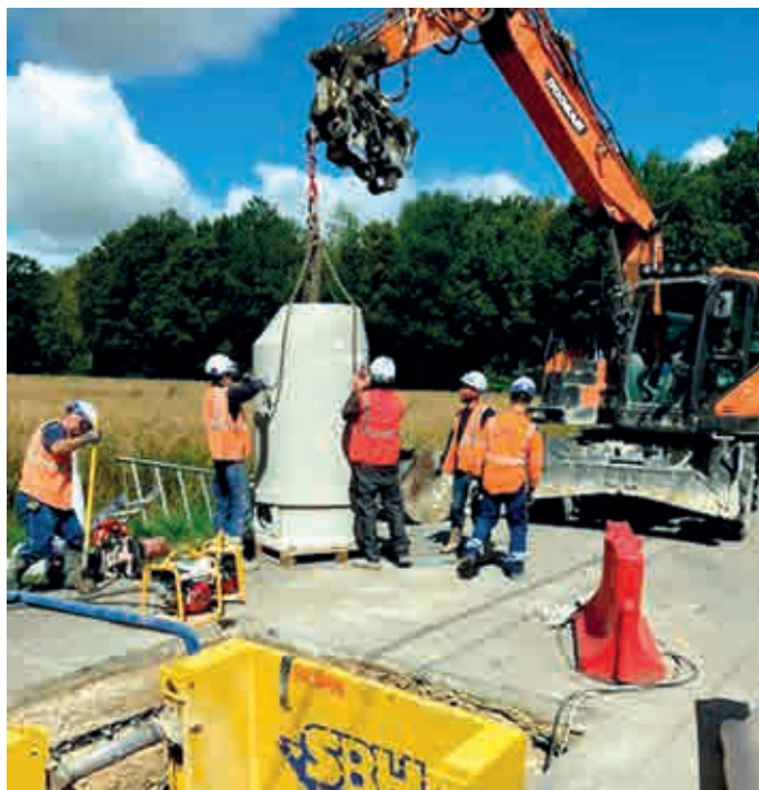
© ACO Pose d'un regard polymère du fabricant ACO pour la modernisation d'un réseau d'assainissement vieillissant et défaillant à Rosnay-L'Hôpital (10).
