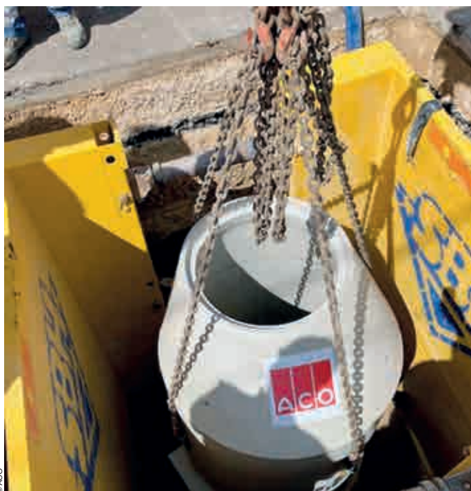
© ACO La conception monolithique, en une seule pièce et sans joint, des regards Aco, garantit à l'ouvrage 100 % d'étanchéité, réduit la manipulation.
