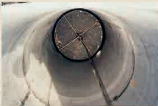
Photo 5 Vue du produit traitant en place dans la porte View of treatment product in place in the gate
