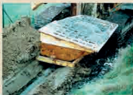
Photo 1 Aspect du produit traitant et vue de la barrière filtrante Appearance of treatment product and view of filtering barrier
