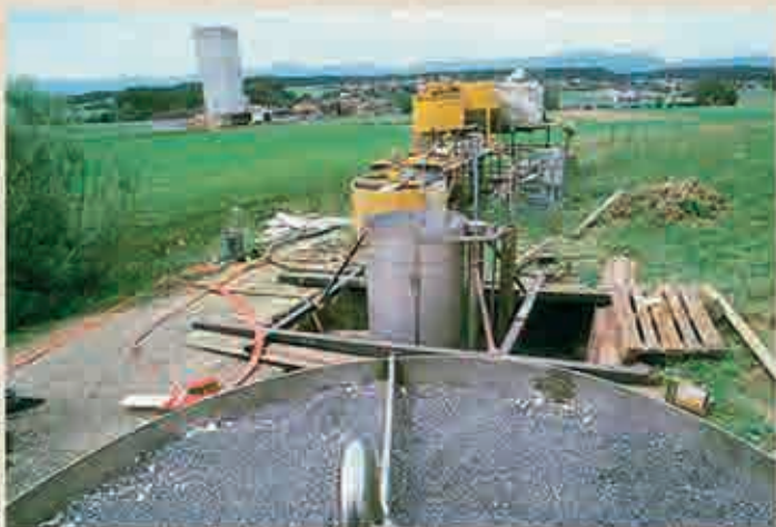
Photo 6 Vue générale du chantier General view of worksite
