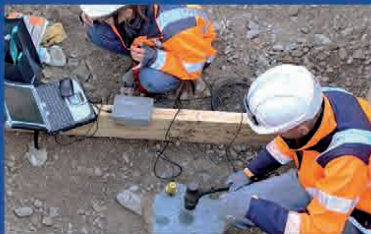
> Contrôle Non Destructif de colonnes de jet grouting
