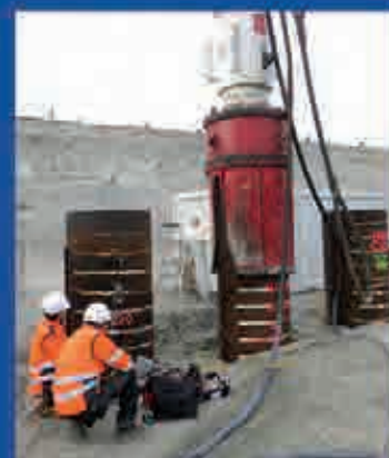
> Suivi de battage de tubes métalliques
