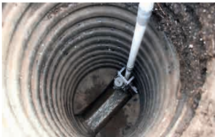
Wavin a conçu un nouveau système de mesure à l'aide de capteurs, qui facilite les campagnes d'évaluation des débits pour valider la performance du réseau.
