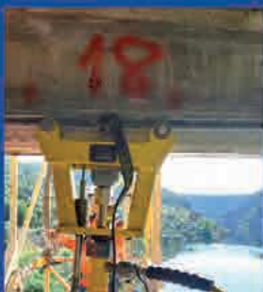
> Essais à l'arbalète - Pont - Espagne
