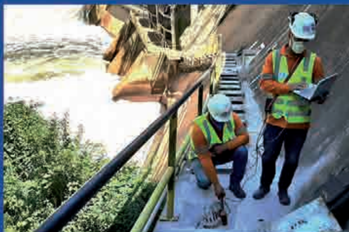
> Essais sur tirants de barrage - détermination de la force de tension
