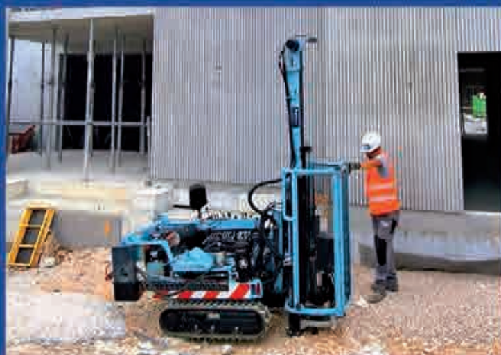
> Contrôle de compactage des remblais
