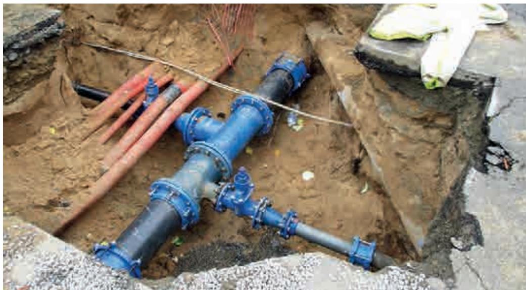
Pose de canalisations enterrées pour l'eau potable.
