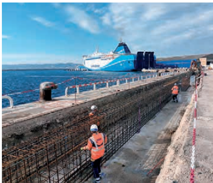
Chantier complexe qui doit aboutir à un traitement durable des eaux lors de l'entretien et de la réparation des navires dans des formes de radoub.
