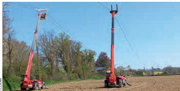
Dans le bocage normand, Loxam a déployé de façon inédite 42 chariots télescopiques pour la pose de pylônes.
