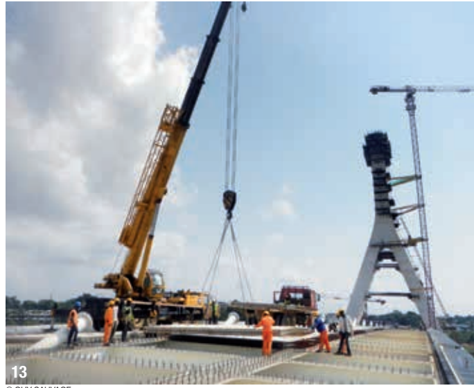
13- Pose des dalles préfabriquées du hourdis. 14- Culée lest C9.
