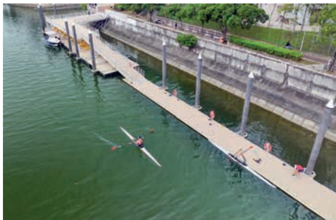
La plateforme d'accès de 8 m de large repose contre le quai grâce à une structure métallique. Elle a vocation à accueillir des compétitions internationales.
