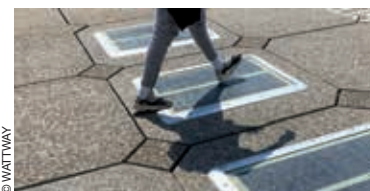
Revêtement photovoltaïque Wattway, testé pendant une année sur le parvis de la Défense.
