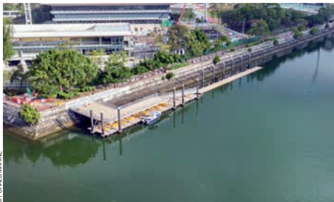
Sur la rivière Shing Mun, à Hong Kong, Poralu Marine a conçu une structure inédite, un ponton à deux étages pour l'aviron.
