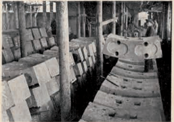
Fig. 3. — La fabrication des claveaux en béton. Fabrication et séchage des blocs (segments annulaires du tunnel).
