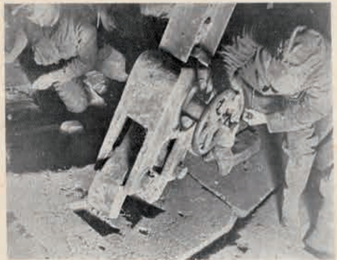
Fig. 4. — Les griffes de l'appareil de mise en place saisissent un claveau en béton.
