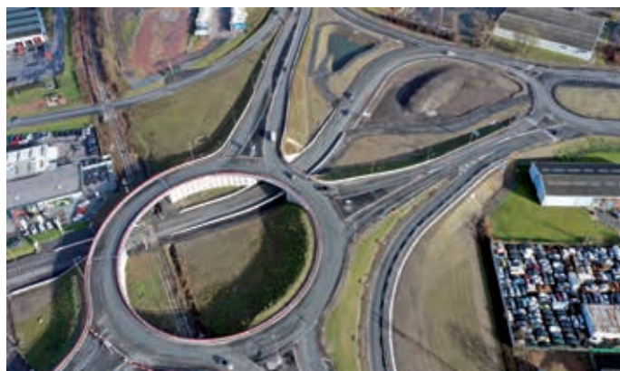
Giratoire de Saint-Saulve, qui a nécessité la création de 4 ouvrages d'art.
