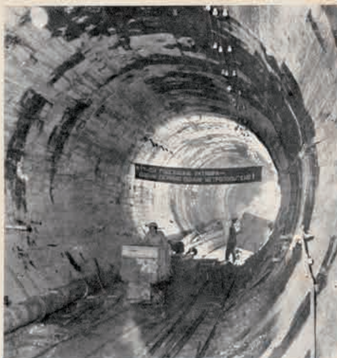
Fig. 10. — Le tunnel brut de décoffrage.
