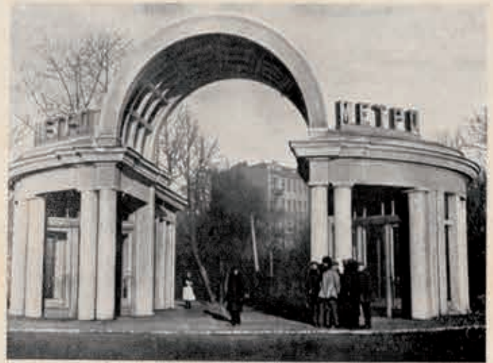
Fig. 17. — Entrée de la station « Palais des Soviets ».
