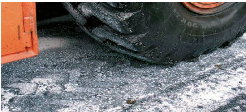
L'épandage de lait de chaux blanchit les routes. Cette technique permet de faire baisser la température au sol d'une dizaine de degrés et peut être utilisée préventivement.
