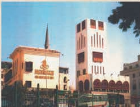
Photo 2 La place El Hussein avec la cheminée à droite El Hussein square with the chimney on the right
