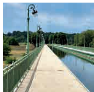
Les berges du pont-canal disposent désormais d'un enrobé sable de couleur claire.
