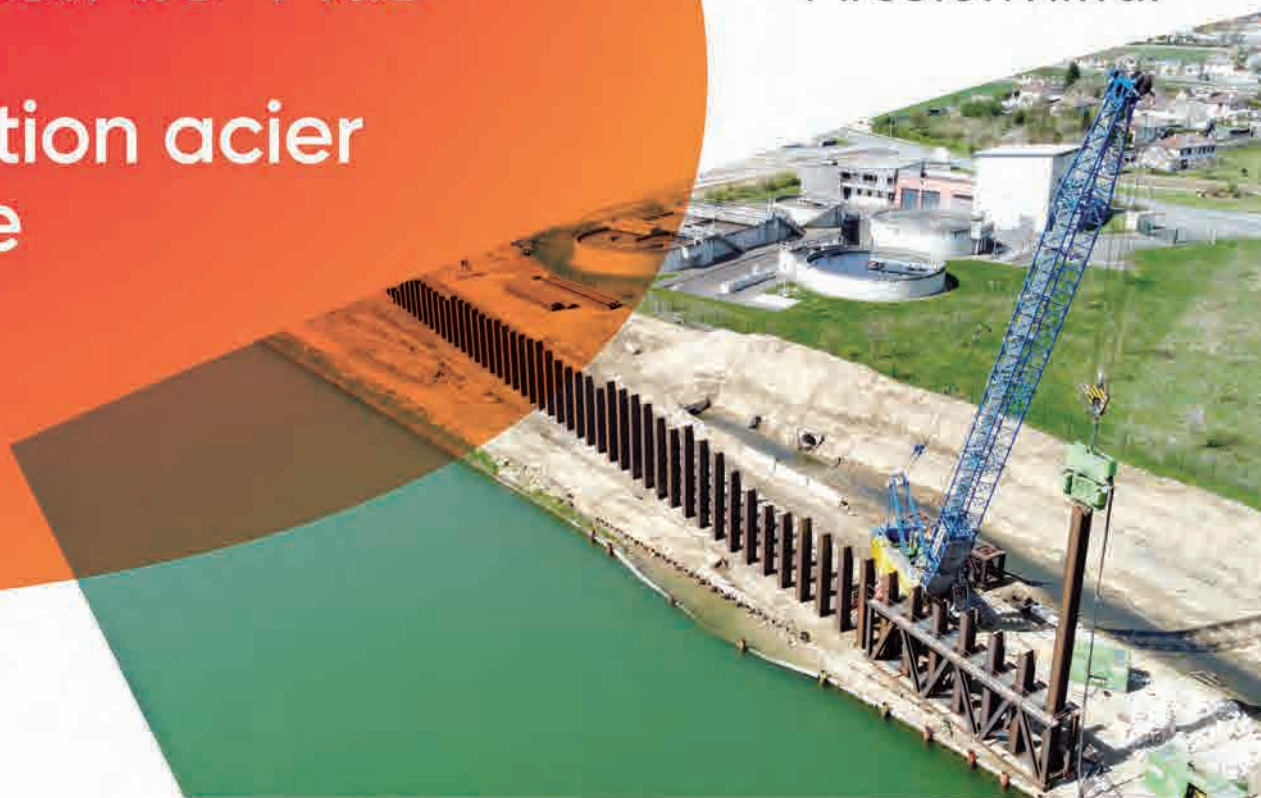
Le quai de Ribécourt sur le Canal Seine Nord Europe est réalisé avec la solution acier EcoSheetPile™ Plus
