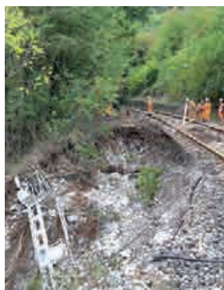
Reconstruction du réseau ferroviaire, ici la gare de Saint-Dalmas-de-Tende, Vallée de la Roya.
