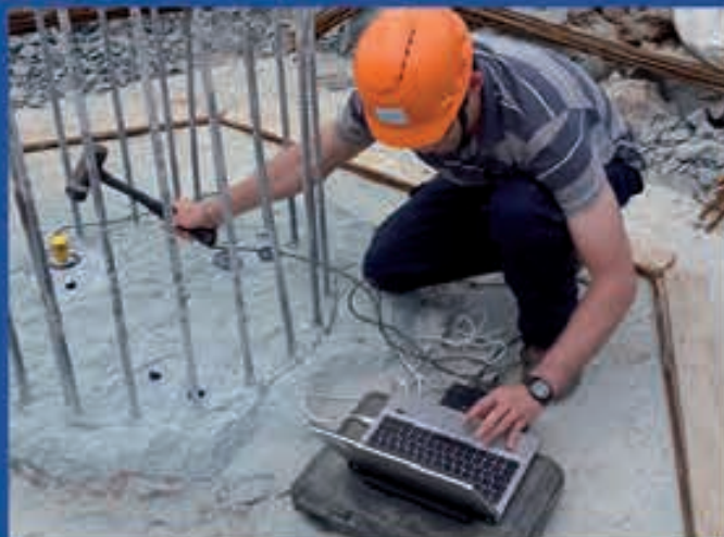
Essais de contrôles des pieux > métro aérien - Sao Paulo
