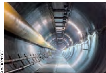
Le tunnel hydroélectrique en cours de creusement entre la station de l'Alpe d'Huez et l'usine d'exploitation de Bourg d'Oisans.
