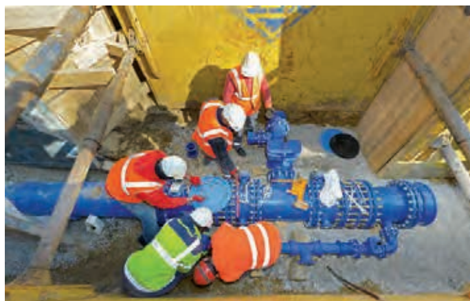
Les Canaliseurs, acteurs d'une gestion durable de l'eau.
