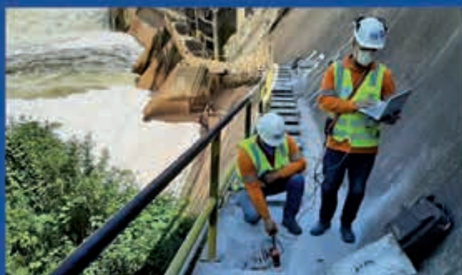
Détermination non destructive des efforts de tension > tirants de barrage - Brésil
