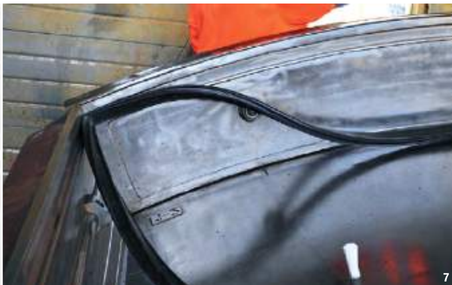
© EIFFAGE GÉNIE CIVIL
