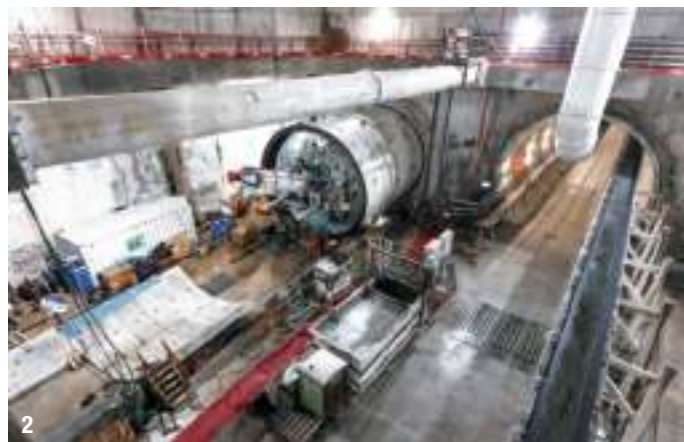
© EIFFAGE GÉNIE CIVIL
