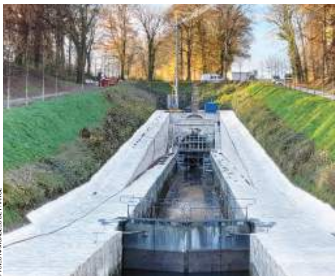
Vue de la tête "est" du tunnel du canal de Saint-Albin (Haute-Saône) dont l'entrée et les parements du soutènement ont été refaits dans une pierre résistante au gel.
