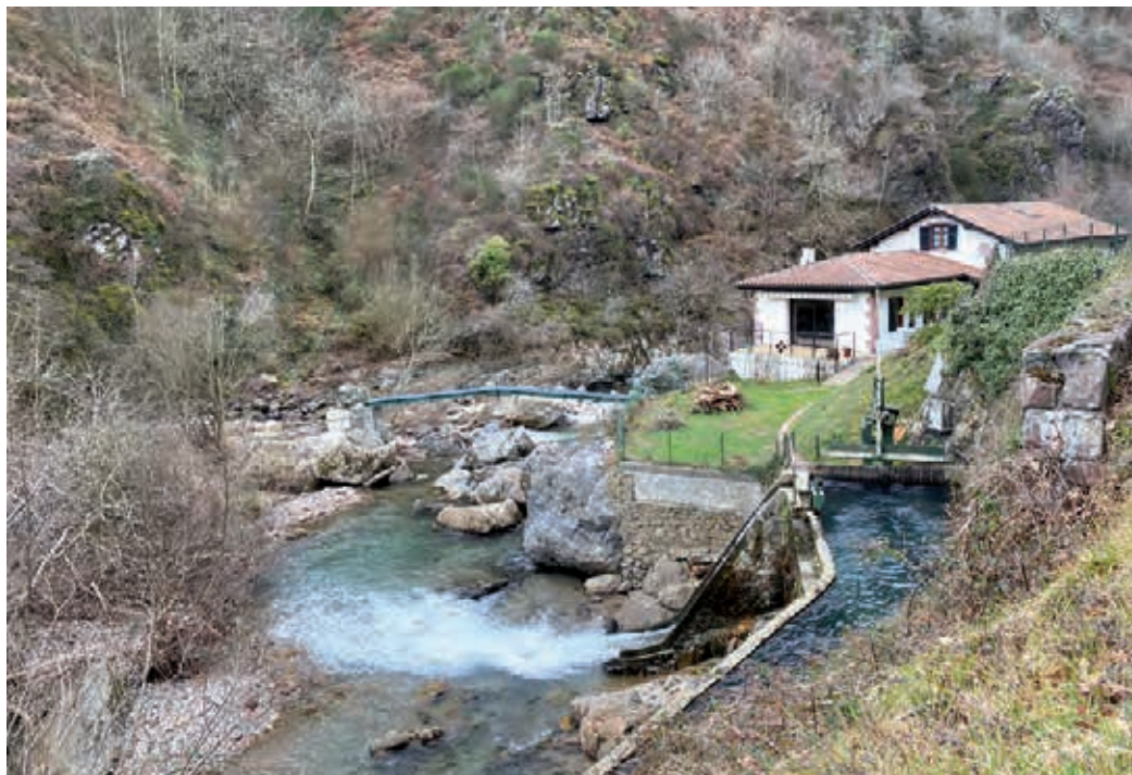
L'hydro-électricité peine à se développer. Utiliser un seuil existant est un bon moyen pour lancer un projet. Ici, ancien moulin équipé sur la Nive des Aldudes (Pyrénées-Atlantiques).
