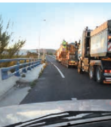
Passage d'un convoi exceptionnel sur un ouvrage d'art de la RD 600 dans l'Hérault.
