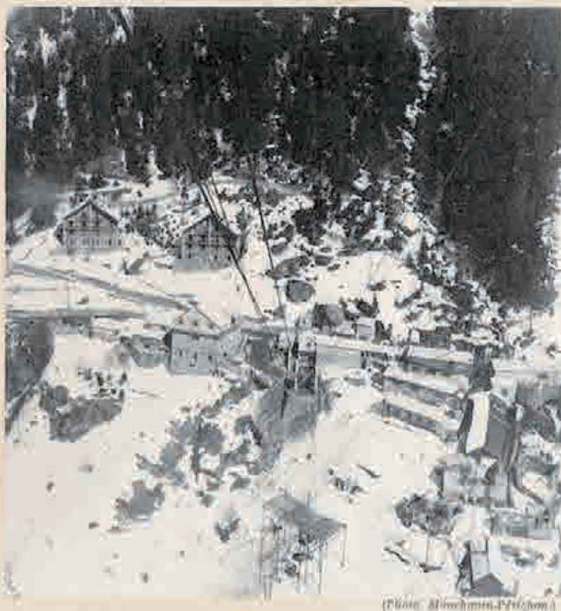
Fig. 1. — Le village de la Raie vu du téléphérique de la fenêtre 9.
