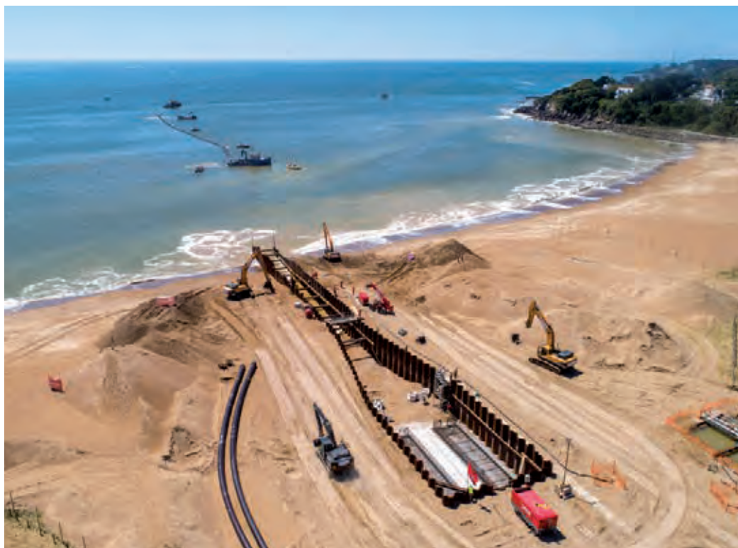
Raccordement électrique du parc éolien offshore de Saint-Nazaire, à La Courance, plage de Saint-Brévin-les-Pins (Loire-Atlantique).
