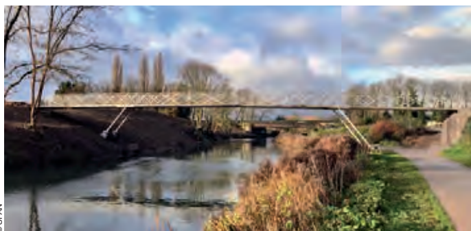
Passerelle sur la Scarpe à Arras, trophée Franchir. Les appuis en béquille sont disposés de façon que les portées intérieures et extérieures soient équilibrées.
