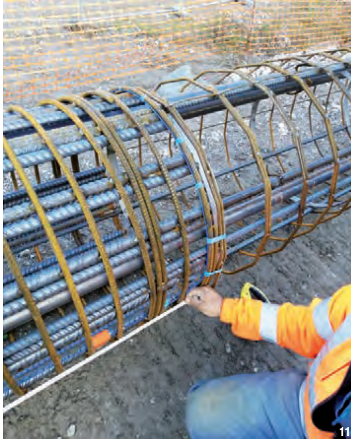
11 - Mise en place de la fibre optique sur une cage d'armature d'un pieu.
