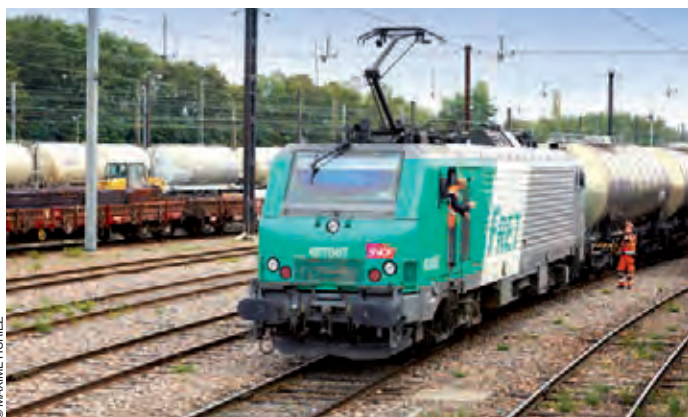
110 millions d'euros serviront à remettre en état des voies de service. Ici, gare de triage de Gevrey-Perrigny (Côte-d'Or).
