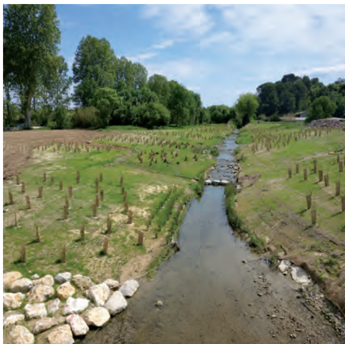
Renaturation de l'Ensigaud à proximité de la déviation de Montagnac (Hérault).
