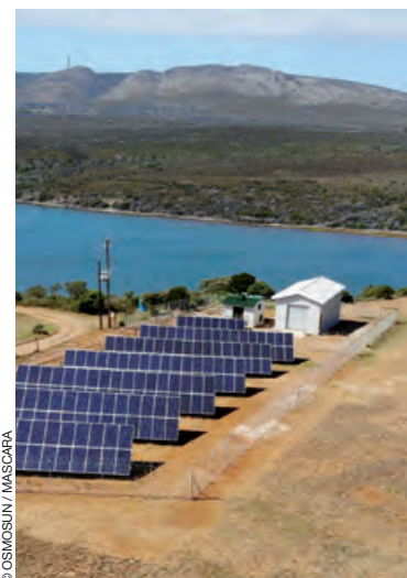
Unité de dessalement d'eau alimentée en électricité solaire sans batterie à Witsand, station balnéaire d'Afrique du Sud.
