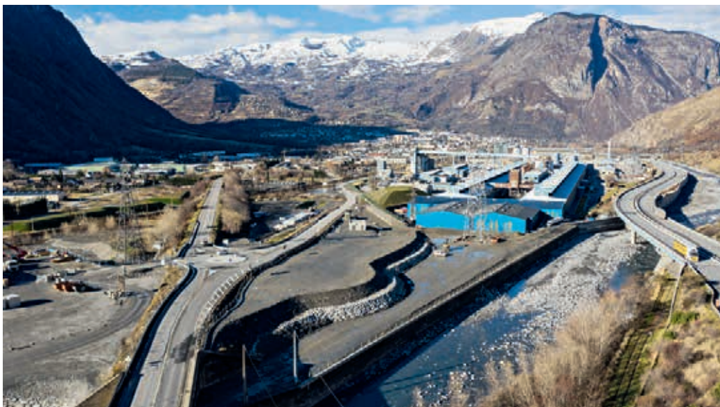
Vinci Construction prend déjà part au tunnel Lyon-Turin avec les travaux préparatoires des puits d'Avrieux (Savoie).
