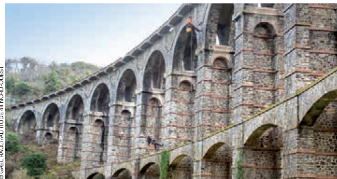
Inspection par des cordistes du viaduc de Douvenant aux abords de Saint-Brieuc (Côtes-d'Armor), ouvrage en maçonnerie actuellement en travaux.
