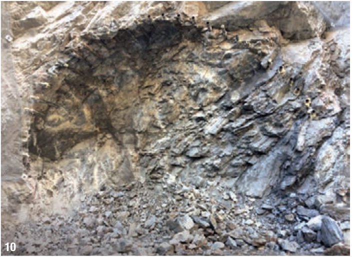
9- Front de taille sous la voûte parapluie aval.
