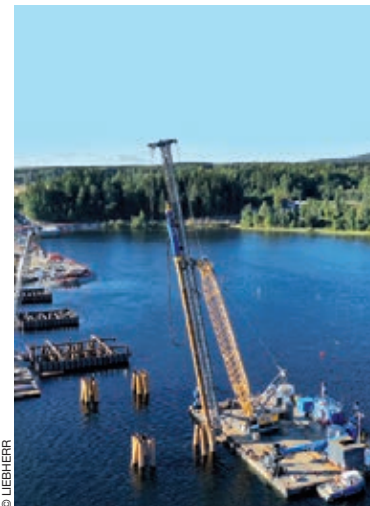
Engin de battage-forage des fondations du pont à 58 m de profondeur.
