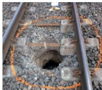
Un fontis de 80 cm de diamètre s'était formé sous les voies en 2015.
