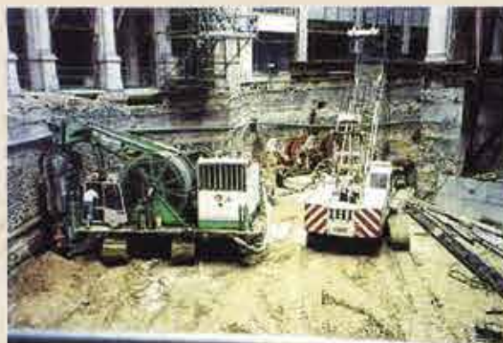
Photo 2 Paroi en cours d'exécution place Edouard VII avec l'hydrofraise compacte HL 4000 Wall being completed on Place Edouard VII with HL 4000 compact hydrocutter
