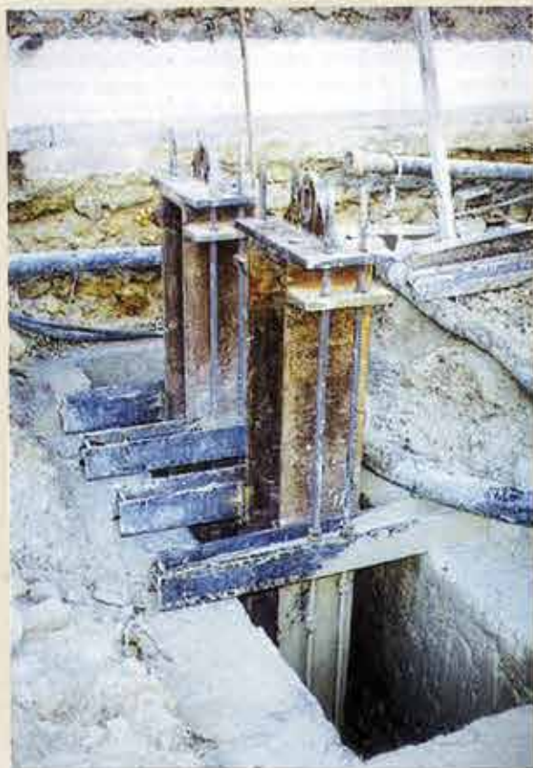
Photo 6 Têtes de positionnement des profilés et barres GEWI de réglage en hauteur Section positioning heads and GEWI height-adjustments bars
