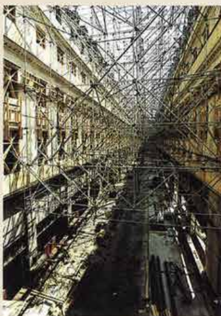
Photo 1 Etalement des façades de la rue Edouard VII La hauteur libre sous étais est de 6,50 m Bracing of façades on Rue Edouard VII The clearance under the braces is 6.5 m
