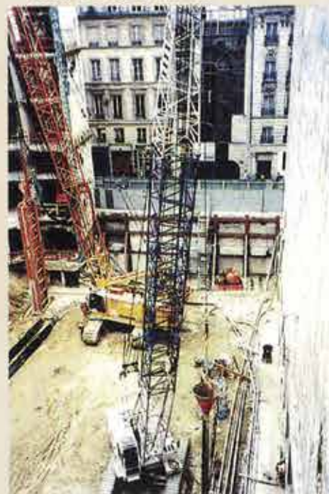
Photo 3 Paroi en cours d'exécution côté rue Caumartin avec l'outillage Hydrofraise HF 4000 Wall being completed on Rue Caumartin side with HF 4000 Hydrocutter tool
