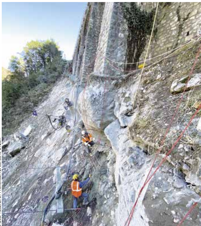
Travaux de confortement d'un mur à arcatures à Fontan (Alpes-Maritimes) suite à la tempête Alex d'octobre.
