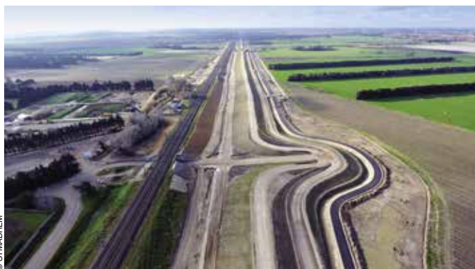
La digue se situe à près de 2 km des berges du Rhône devant un remblai ferroviaire.
