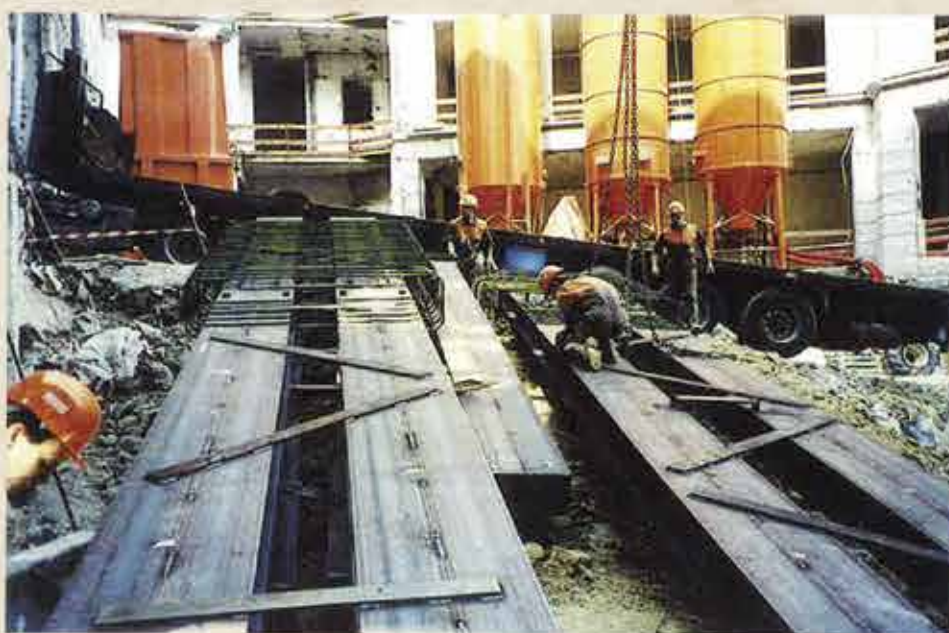
Photo 5 Déchargement de profilés inférieurs préassemblés Pre-assembled lower sections being unloaded
