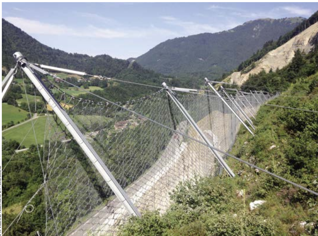
Défecteur avaloir freiné, en protection d'une route départementale sous carrière en Haute-Savoie.
