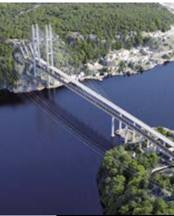
Vue du futur viaduc de Grenland, un des ouvrages sur le tronçon E18.
