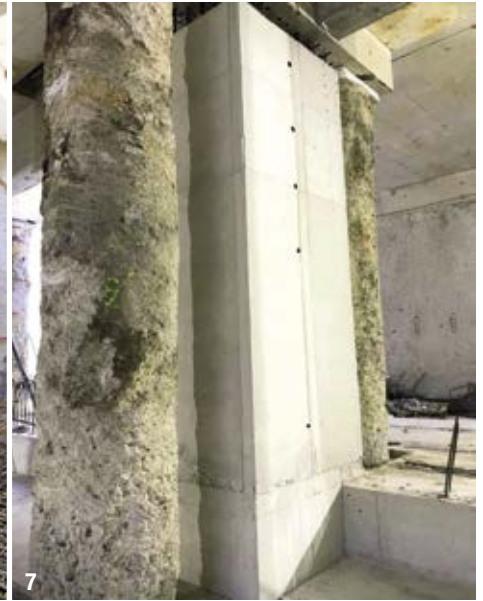
7- Poteaux provisoires et poteau définitif.
