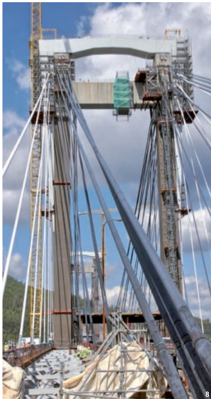
8- Vue des ancrages HD installés par Freyssinet.
