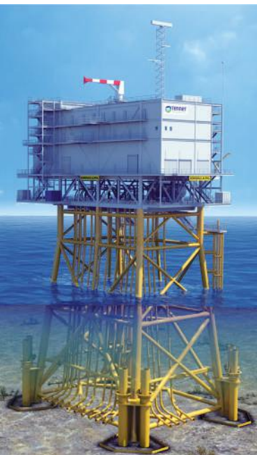
La structure supérieure mesure 47 m de long par 35 de large et 25 de haut.
