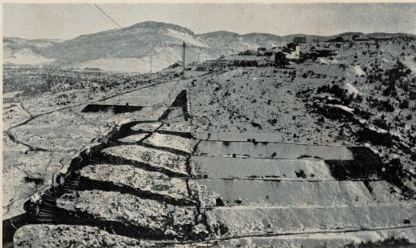
Fig. 3. — Fouille rive gauche du barrage.
