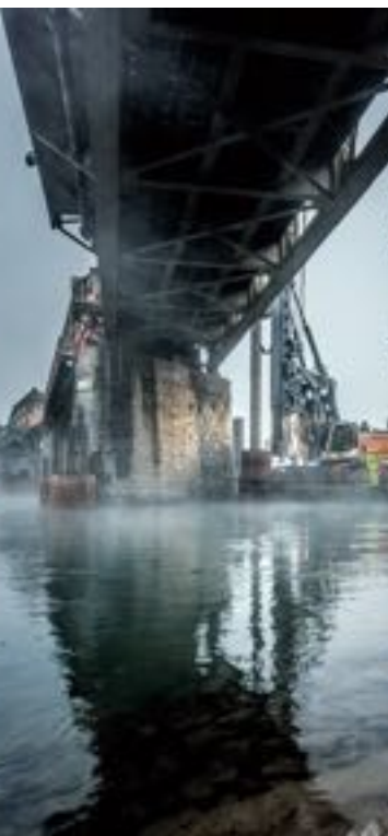
Chaque pile est renforcée par 4 pieux.
