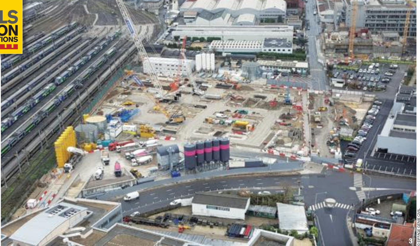
© EIFFAGE GÉNIE CIVIL 3
