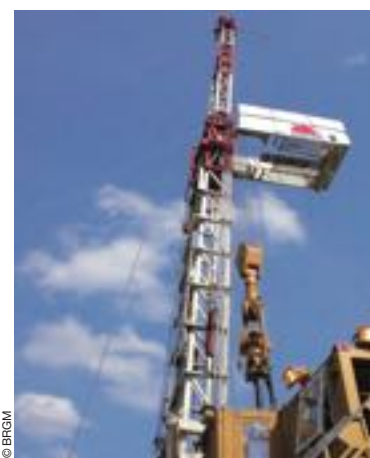
Mât de forage d'un puits géothermique profond.
