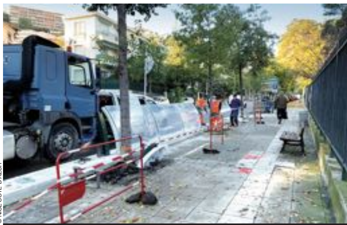
Écrans acoustiques bas à l'essai à Nice (Alpes-Maritimes).
