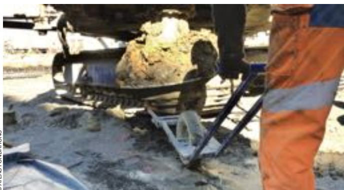
La brouette se glisse sous la tarière pour changer la pointe de forage.
