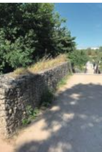
Mur en gabion contenant les gros morceaux de béton.
