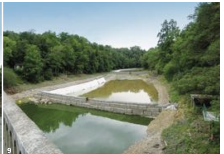
9 © DDTM50/MISSION BARRAGES DE LA SELUNE
