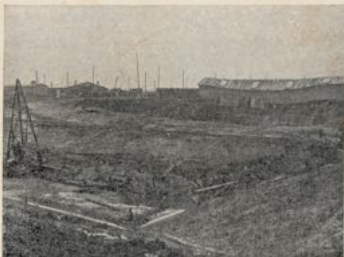
Fig. 5. — Dérobage des talus exécutés dans le Klei.
