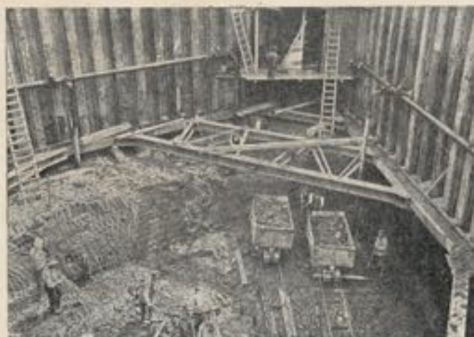
Fig. 30. — Fouille pour la fondation du pont tournant.
