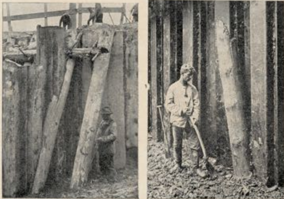
Fig. 15 et 16. — Palplanches Larssen battues à travers des pieux en bois.
