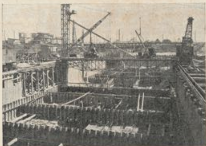
Fig. 20. — Chantier de la tête amont.
