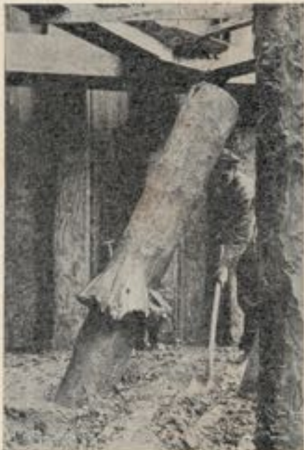
Fig. 22. — Anciens pieux en bois abîmés par un battage trop acharné.
