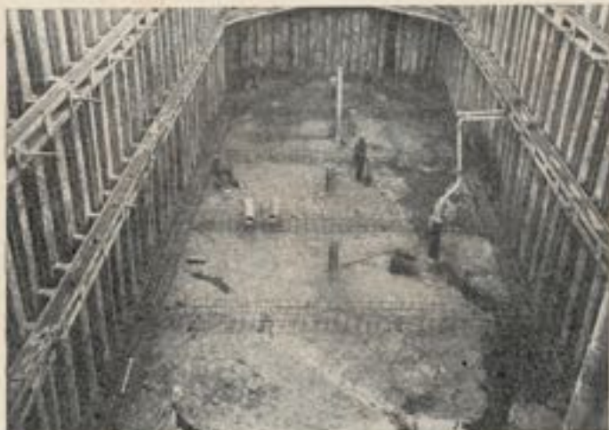
Fig. 19. — Pose des armatures dans un compartiment de la tête aval.
