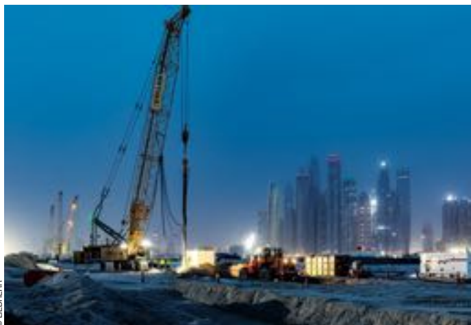
La grue sur chenilles équipée d'un outil de vibro flottation tasse le sable sur 19 m à Dubaï.
