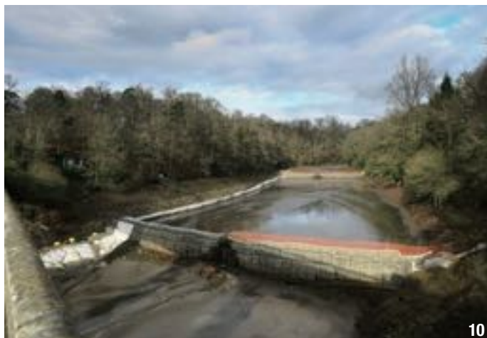
© DDTM50/MISSION BARRAGES DE LA SELUNE
