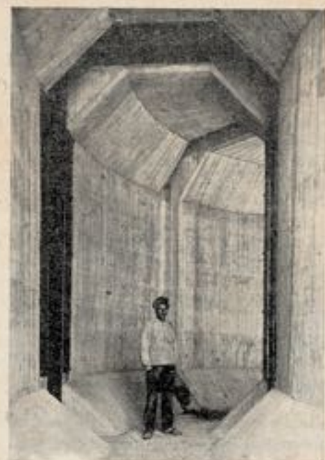
Fig. 13. — Vue d'un aqueduc de vidange et de remplissage.
