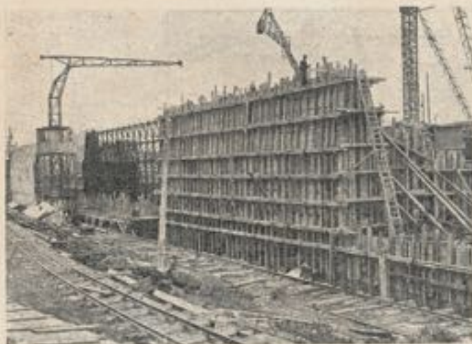
Fig. 27. — Coffrage des bajoyers.
