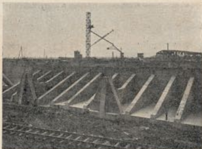
Fig. 28. — La face côté terre des murs de quai terminés.
