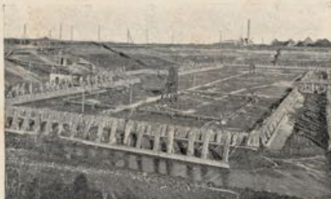
Fig. 7. — L'installation d'essai de rabattement dans la tête amont.
