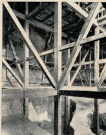
Fig 11. — Rocher des ours, détail de la charpente.
