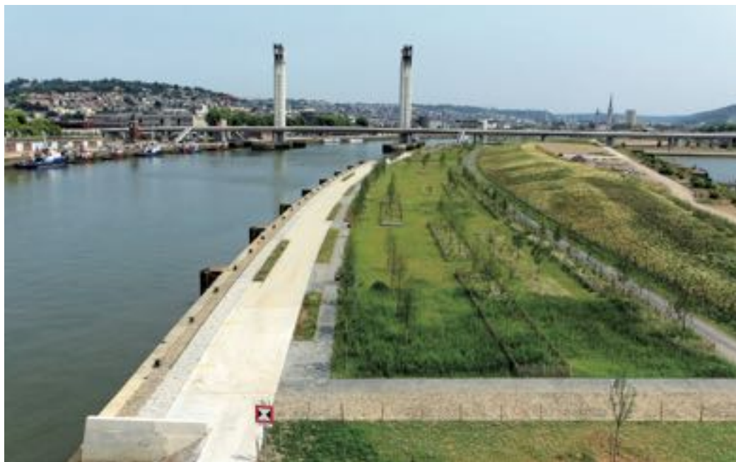
Sur la presqu'île Rollet, près du pont Flaubert à Rouen, la butte de terre créée avec les déblais, à droite de la voie en bitume, va devenir une forêt.
