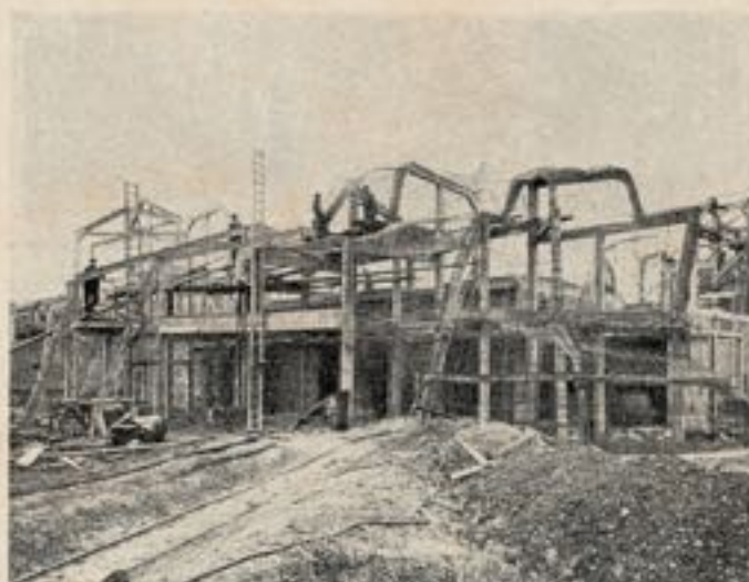
Fig. 4. — Ce cliché montre parfaitement la construction de la charpente et des chevalets, de même que la pose du treillis d'armatures devant constituer le support de la paroi du rocher.
