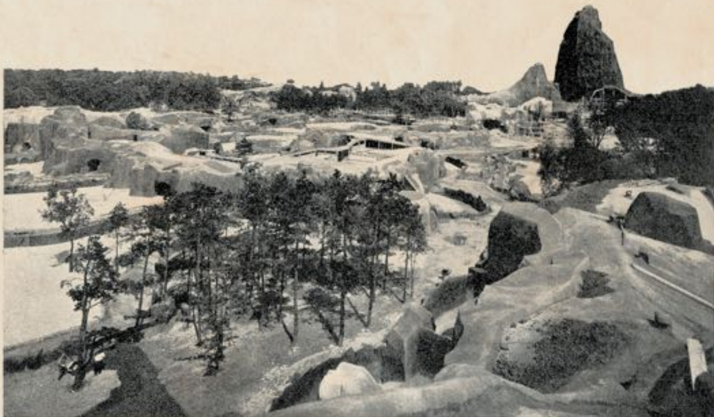
Fig. 1. — Parc zoologique de Vincennes. Vue partielle du chantier. Au premier plan, l'extrémité nord du rocher des ours sur laquelle on distingue la profonde cuvette destinée à contenir la terre qui permettra à la végétation de prendre possession du rocher. Au second plan, les rochers des bovidés et des tapirs ; puis, au fond, la fauveris et le grand rocher en cours de construction.
