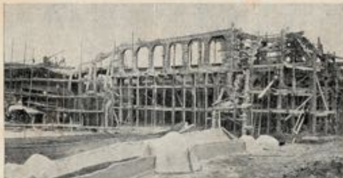
Fig. 6. — Vue partielle du bâtiment au 12 mars 1934.
