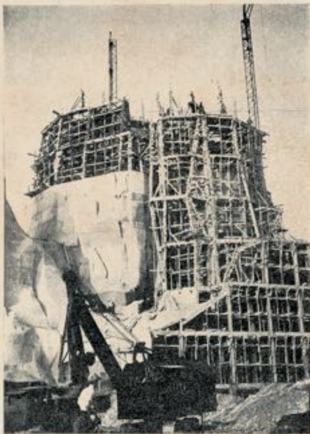
Fig. 15. — La charpente du grand rocher (début mars 1934, hauteur atteinte : 50 mètres). Remarquer le réservoir circulaire enfermé dans la charpente à mi-hauteur et à droite.
