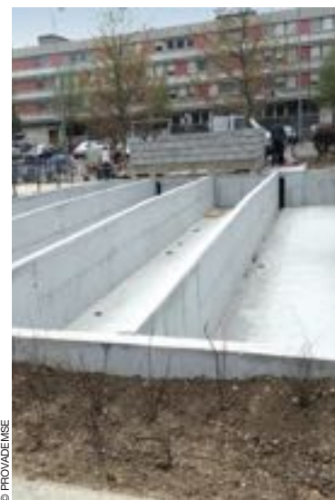
Planches routières instrumentées pour l'évaluation environnementale de matériaux, avant remplissage.
