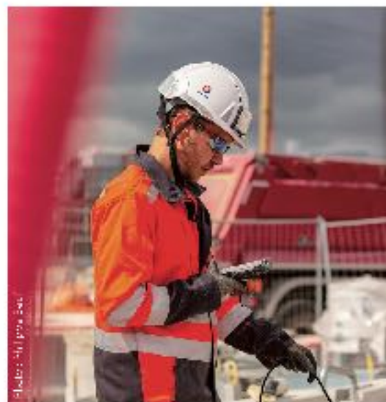
Mesures inclinométriques en forage.
