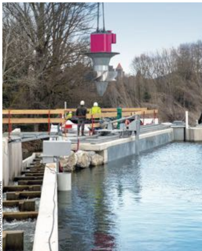
Arrivée de la turbine électrique sur le seuil Païchéro en janvier, hélice de 194 cm de diamètre à 5 pales.
