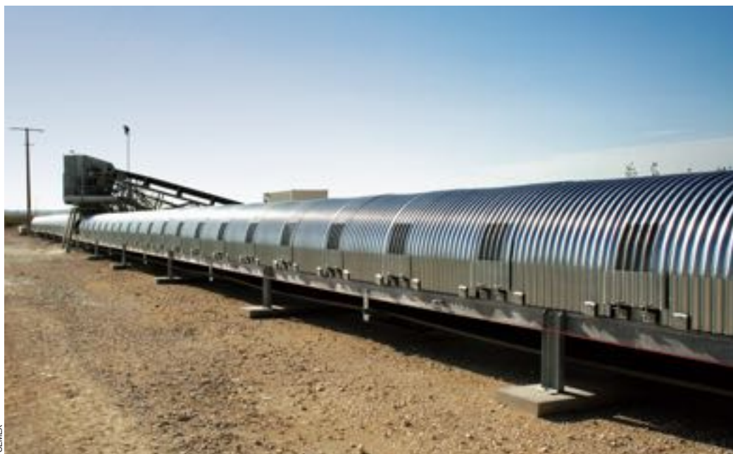
Les bandes transporteuses, électriques, limitent la dépendance au carburant. Ici, convoyeur carrossé à Pécycy (Seine-et-Marne) afin d'atténuer l'émission de bruit et de poussières.
