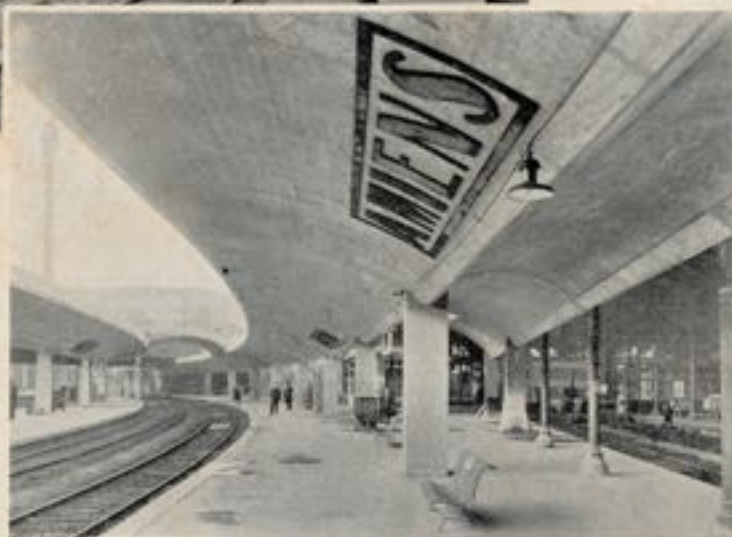
Fig. 8 Passages planchés sous cintres
