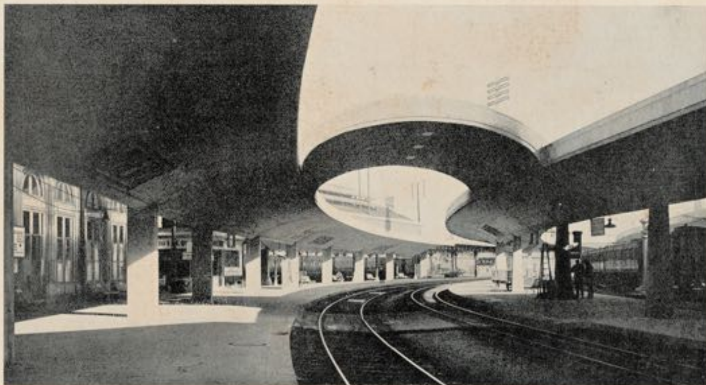
Fig. 1. — Vue des abris en double auvent des quais à voyageurs de la gare d'Amiens
