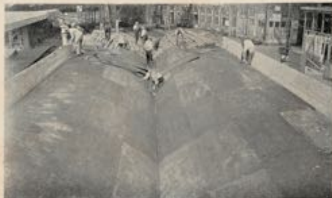
Fig. 7. — Coffrage des membranes en contreplaqué
