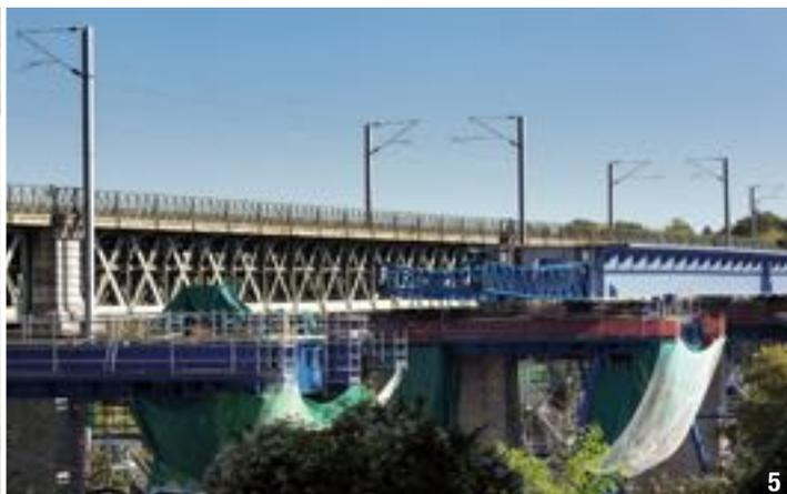
Les palées situées autour des piles sont construites sur des semelles en béton armé de 1,50 m d'épaisseur, fondées sur 16 pieux Ø 1000 mm d'une longueur de 20 à 24 m.
