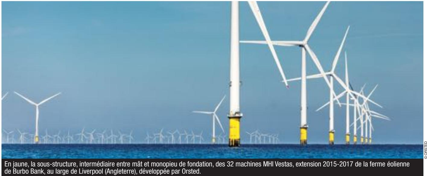
En jaune, la sous-structure, intermédiaire entre mât et monopieu de fondation, des 32 machines MHI Vestas, extension 2015-2017 de la ferme éolienne de Burbo Bank, au large de Liverpool (Angleterre), développée par Orsted.
