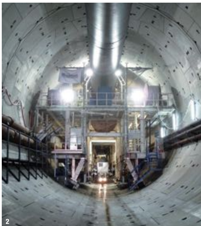
1- Dispositif de congélation d'un rameau. 2- Vue de l'intérieur d'un des deux tunnels.
