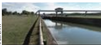
Seuil d'Ormes (Saône-et-Loire) qui va être équipé d'une centrale électrique de 1,8 MW en partenariat entre VNF et JMB Hydro.
