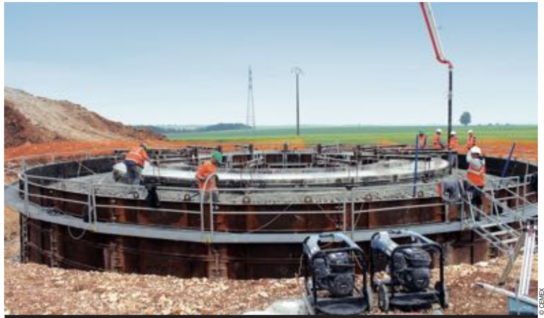
Massif de fondation de 600 m 3 de béton.
