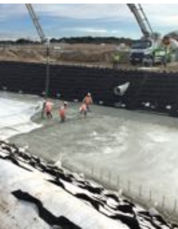
Bassin de rétention à Miramas (Bouches-du-Rhône) où la fibre a été testée.
