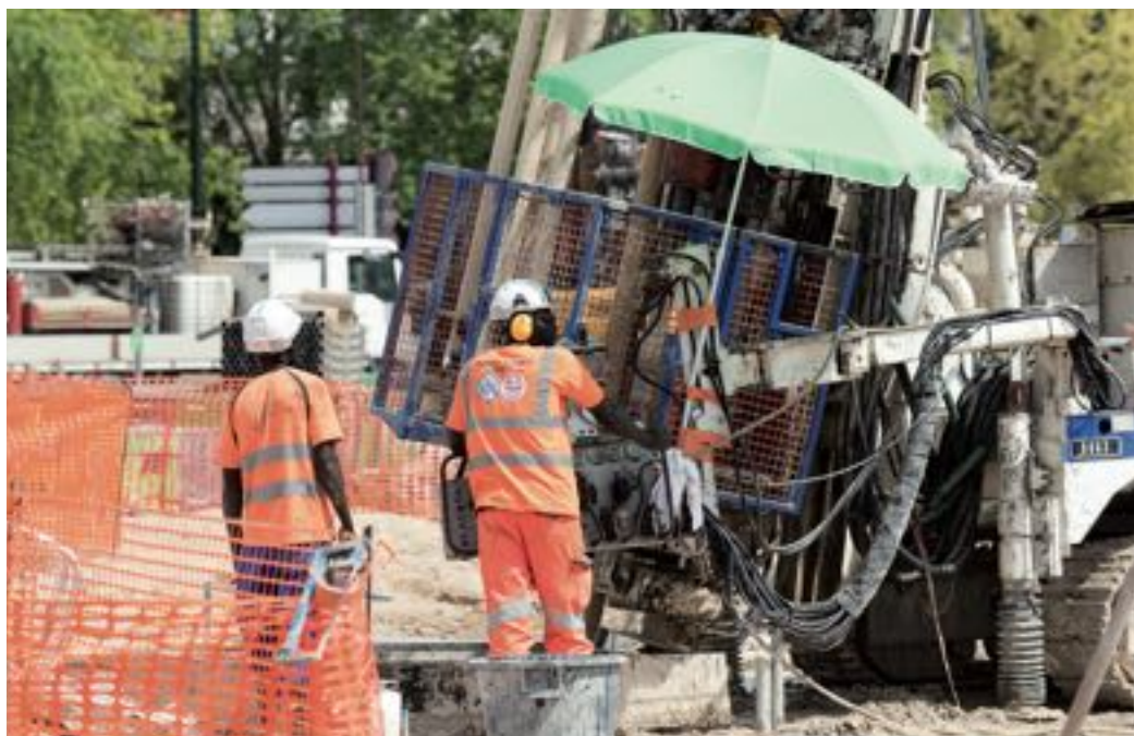
Les carrières sont comblées à partir de la surface, ici dans le secteur de Bagneux (Hauts-de-Seine).
