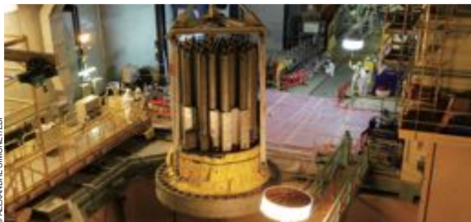
Cœur du réacteur à eau pressurisée de la centrale de Chooz (Ardennes) en cours de démantèlement.
