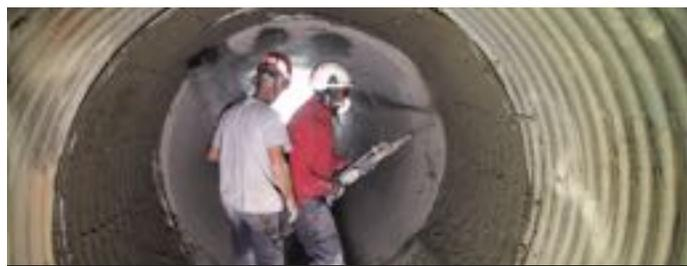
Projection de mortier avant pose du treillis en carbone sur une buse de l'A75.
