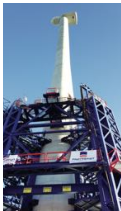
© PHOTO THÈQUE SOLE TRANCHE FREYSSINET / LAURENT CHARTIER
