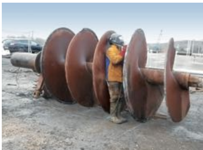
Une tarière de 600 mm puis une de 1 800 mm (photo) ont creusé le passage sous une 4 voies.
