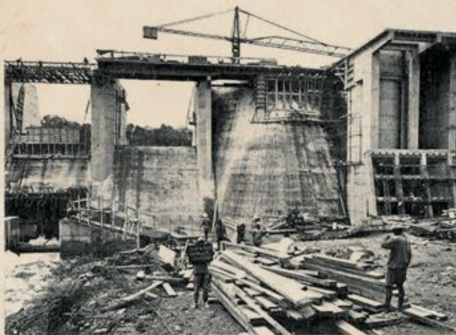
Ensemble : évacuateur, dérivation provisoire phase II, voûte et prise d'eau. Vue d'amont (8 août 1963).
