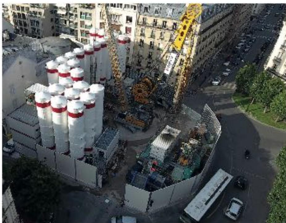
**Eiffage Fondations réalise actuellement un puits de ventilation pour le prolongement du RER E à l'Ouest (EOLE) à Neuilly-sur-Seine (92).**
