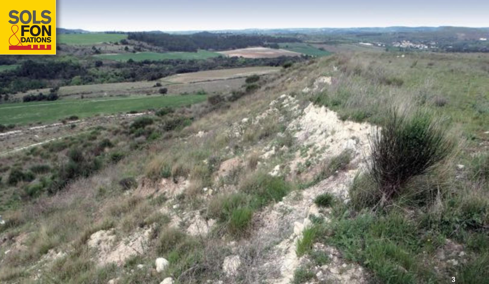
Les argiles qui constituent la digue en partie haute ne sont pas protégées des intempéries, ce qui implique une dégradation progressive des caractéristiques mécaniques et notamment de la cohésion qui va tendre vers 0. La surface de rupture étudiée correspond au glissement observé sur site.
