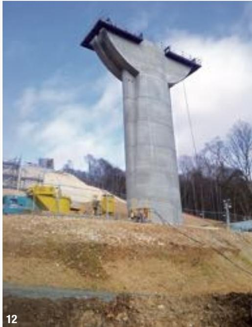
constructeur, afin de détecter d'éventuels tassements ou déformations induits par les travaux de jet grouting. Cette mesure a été doublée avec la mise en place de dispositifs de contrôle visuel immédiat (niveaux et pendules) pour permettre à l'entreprise un contrôle continu des éventuels déplacements.
