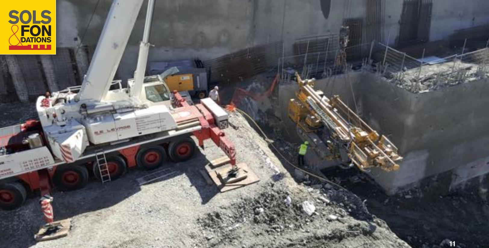
Les spécificités géotechniques du site étant peu favorables à la réalisation d'éléments de fondation profonde de grosse section, la conception des soutènements s'est orientée vers une solution mixte : parois lutéliennes dans zones de forte hauteur de terrassement et les zones à proximité d'avoisinants sensibles, parois clouées dans les zones moins sensibles aux déplacements.
