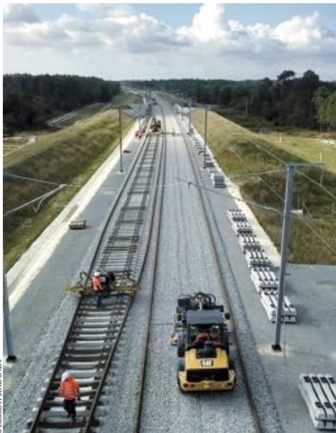
Chantier Egis sur la LGV SEA : pose de longs rails soudés en Gironde (2015).
