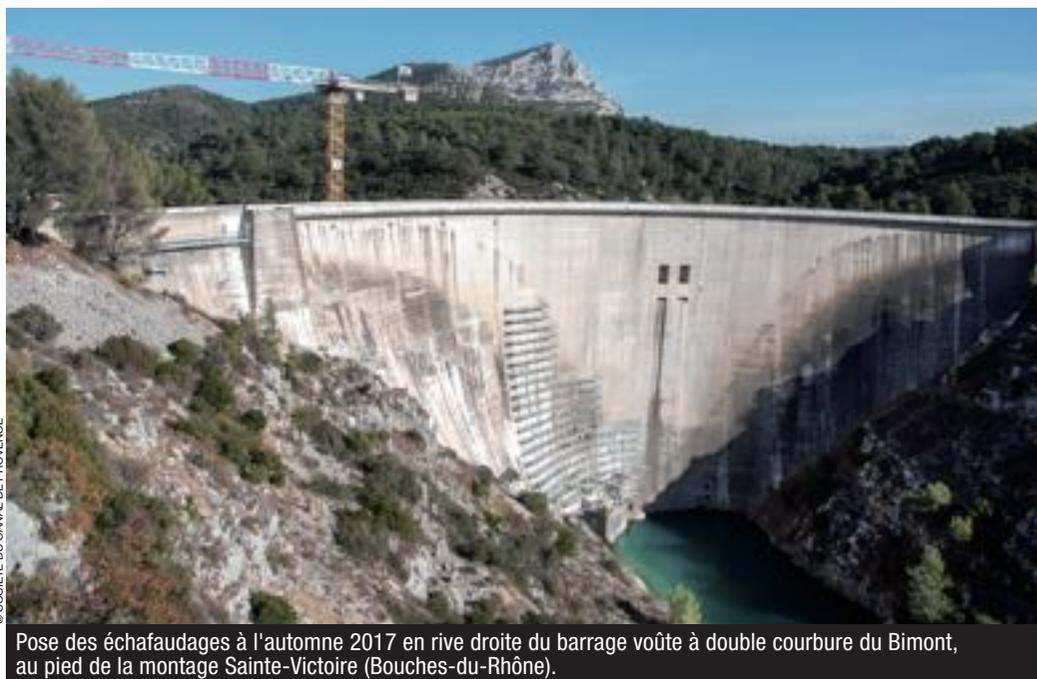
Pose des échafaudages à l'automne 2017 en rive droite du barrage voûte à double courbure du Bimont, au pied de la montagne Sainte-Victoire (Bouches-du-Rhône).
