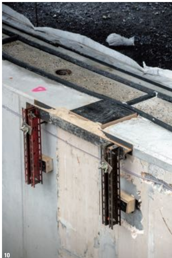
10 © BOUYGUES TRAVAUX PUBLICS
