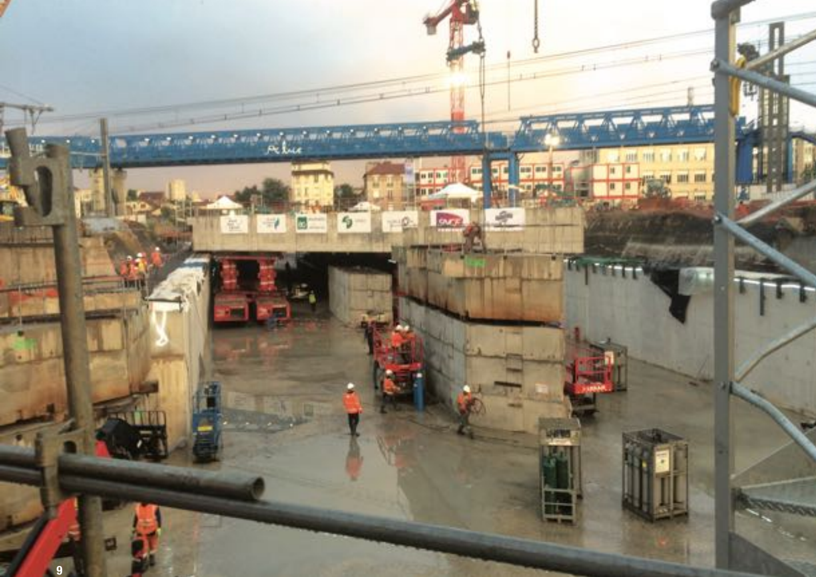
9 © BOUYGUES TRAVAUX PUBLICS
