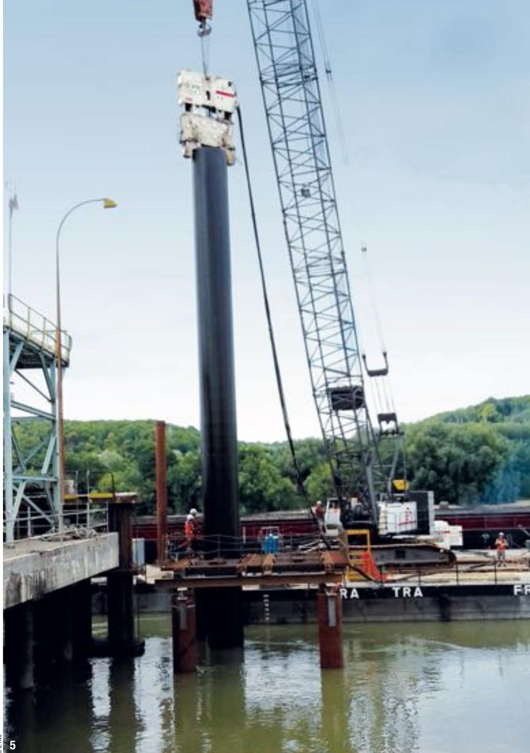
**5- Vibrofonçage d'un tube.**
