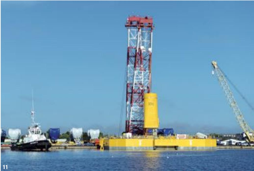
d'ancrage ; ou enfin le tube métallique (I-tube) protégeant le départ de l'ombilical d'export de l'électricité. Les parties émergées du flotteur sont également peintes en jaune conformément à la réglementation sur le balisage des structures en mer.
