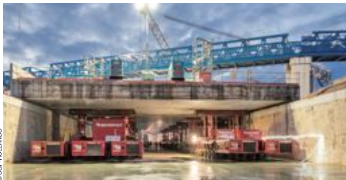
Ripage d'une dalle de 7 000 tonnes, toit de la future station Fort d'Issy-Vanves-Clamart (Hauts-de-Seine), au croisement avec une ligne de train.
