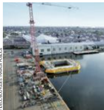
Construction de l'anneau carré flottant en béton à Saint-Nazaire.
