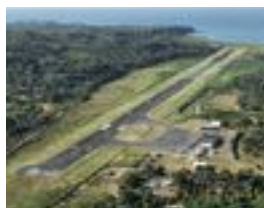
Aéroport de l'île de Nosy Be (Madagascar) avant travaux.
