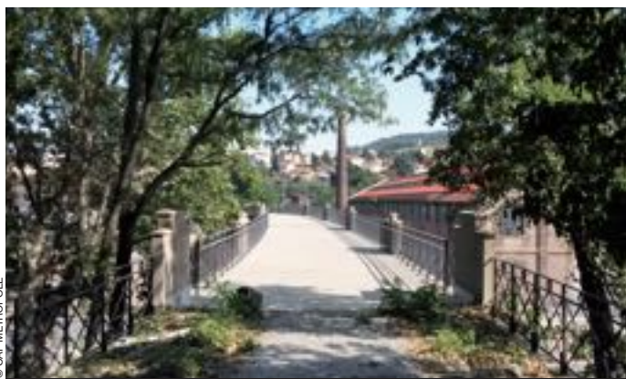
Le viaduc ferroviaire des anciennes aciéries a été réaménagé en promenade.
