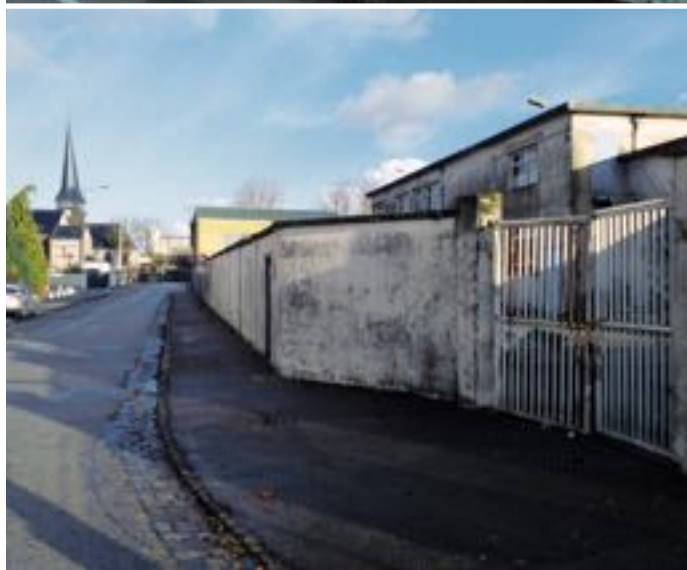
Deux vues des anciens abattoirs du Petit-Quévilly (Seine-Maritime). L'EPF Normandie se charge du portage foncier et de la démolition commencée en août, avant création d'un parc urbain avec logements par RNA pour la commune.
