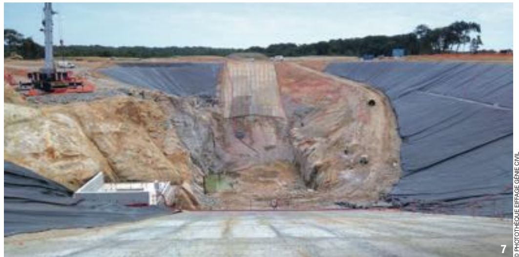
© PHOTO THÉRIQUE EIFFAGE GÉNIE CIVIL
