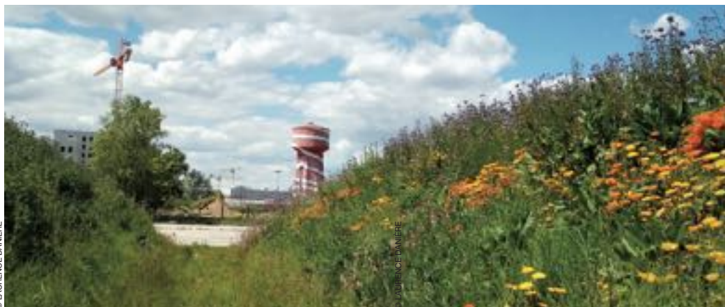
Terres végétales récupérées d'un chantier de parking, stockées en andains en attente de l'aménagement d'un espace public planté, au Carrée de soie (Lyon métropole).
