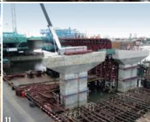
à chaque côté de la pile centrale. La longueur totale d'un fléau est donc de  $16 \times 3,4 \text{ m} + 9,2 \text{ m} + 16 \times 3,4 \text{ m} = 118 \text{ m}$ . La longueur des voussoirs de clavage central est de 2,30 m. Au total, il y a quatre fléaux pour les deux tabliers parallèles.
