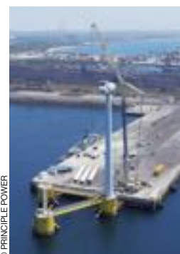
Éolienne à quai sur ses flotteurs.
